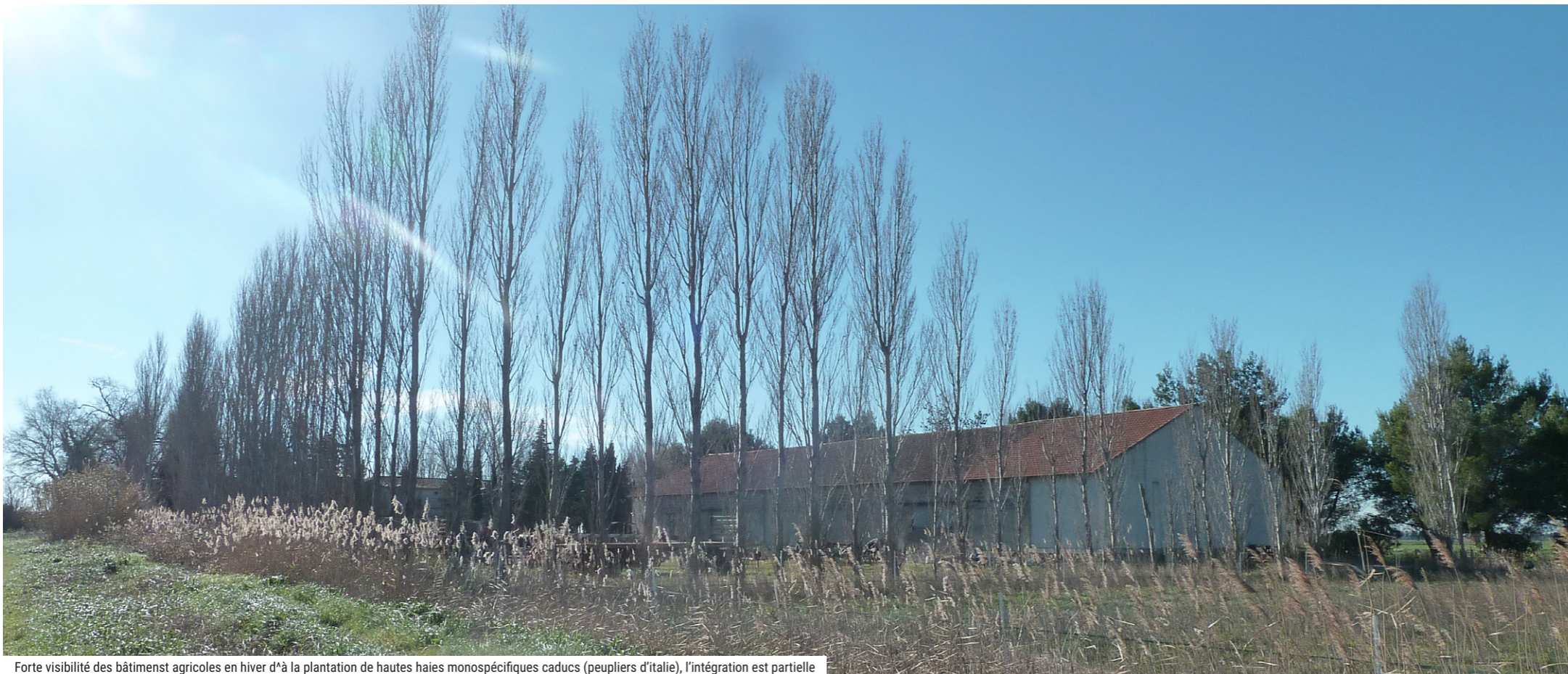
Forte visibilité des bâtimenst agricoles en hiver d*à la plantation de hautes haies monospécifiques caducs (peupliers d'italie), l'intégration est partielle
